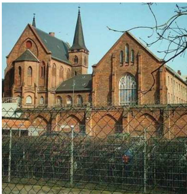
Die JVA Bremen-Oslebshausen mit Kirche
